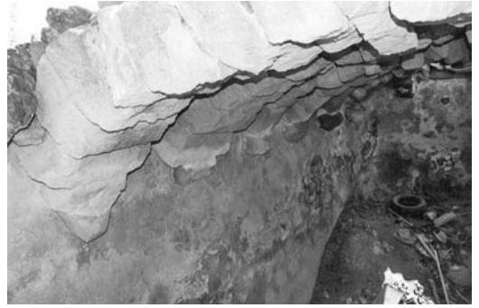
Figura 11 Vista interior de un aljibe en Playa Quemada
