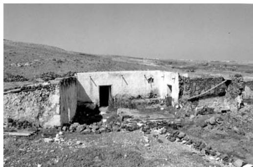
Figura 2 Vivienda en Tías. Las cubiertas desaguan al patio mediante las gárgolas. En el patio se puede observar el trasdós del aljibe
