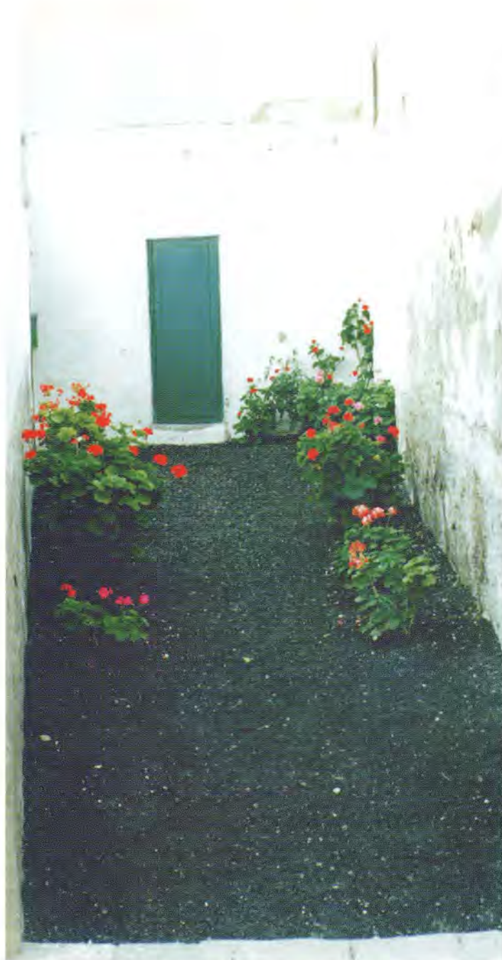
Utilización del rofe como material para pavimentar un pasaje urbano
