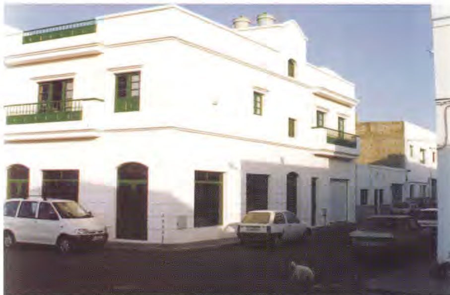
Zona donde pasaba el barranco de la Condesa, en Titerroy y en donde se encontraban las estructuras arquitecturales, posiblemente habitacionales de la cultura aborigen
