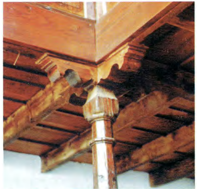
Detalle de la columna y su zapata en el patio de la Casa Arroyo
