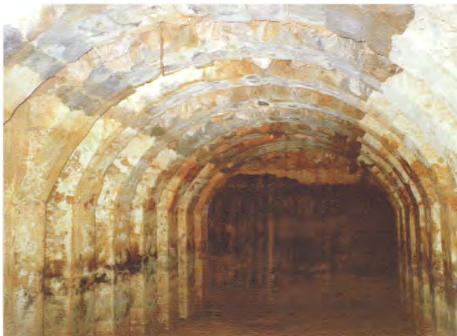
Aljibe con arcos que descansan sobre pilastras
