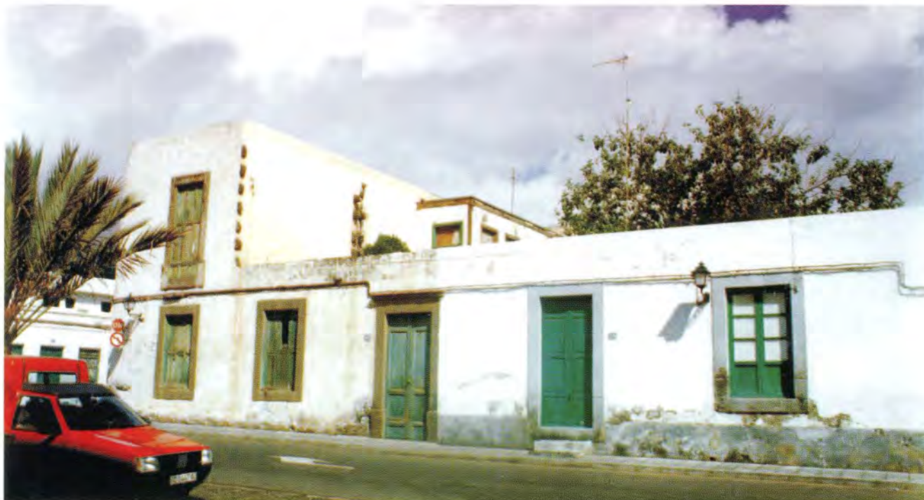
El antiguo hospital de Arrecife queda como válido testimonio de la calidad constructiva de los pioneros de la ciudad
