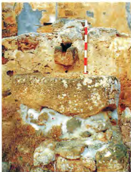
Canal de brocal a pileta
