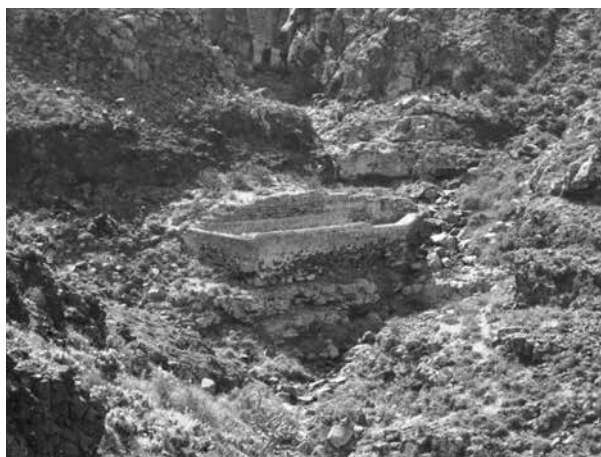
Imagen 3.3. Estanque del Barranco de Maramajo en Tegüise. Elaboración propia
