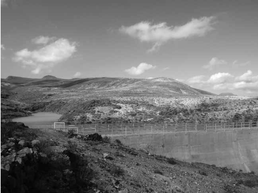
Imagen 3.6. Presa de Mala. Elaboración propia.
