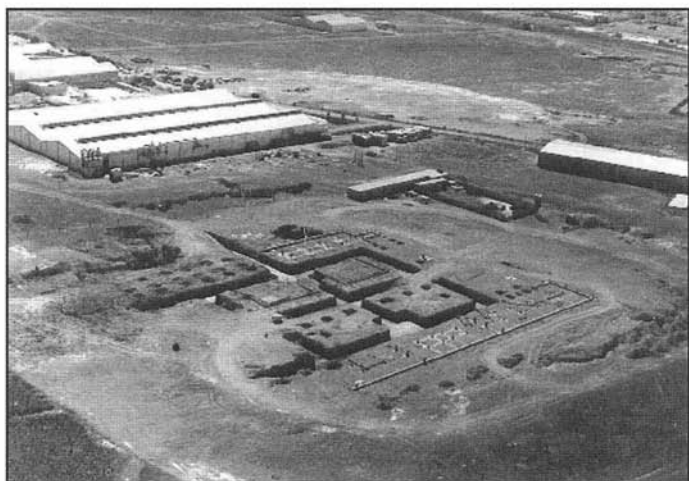
Construcción del Hospital General.
