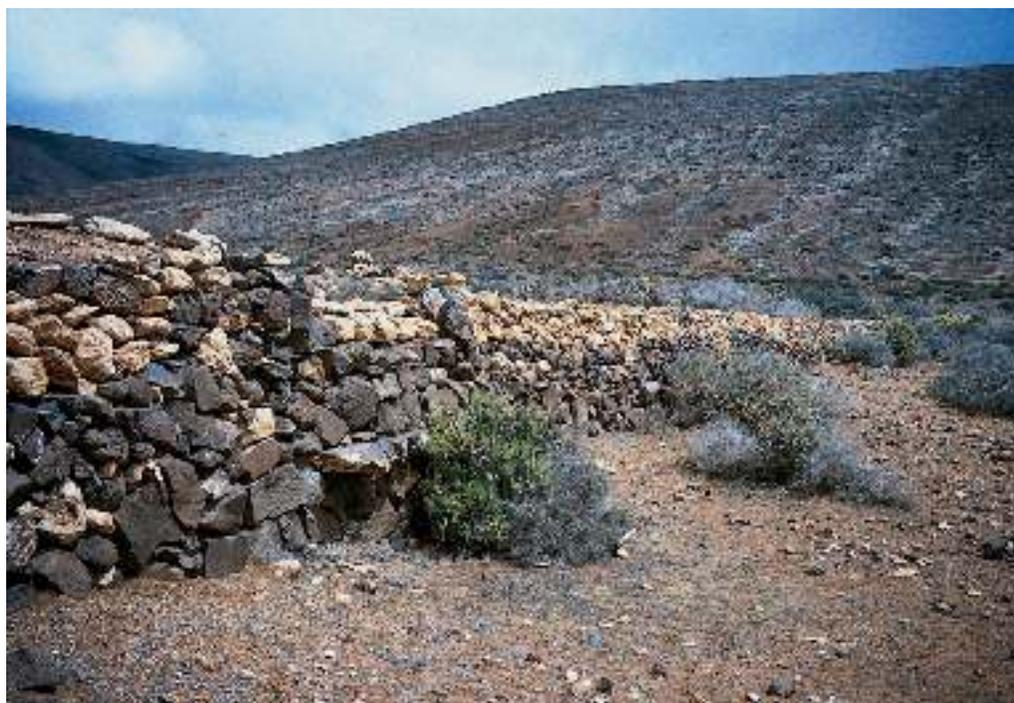
**Figura 10:** Pared de una gavia abandonada en la Vega de San José, Tegüise, con signos de haber sido encabezada. Las lajas de piedra sobresalientes al pie del desagüe evitaban que el agua incidiera directamente sobre la base de la pared y la socavara.
