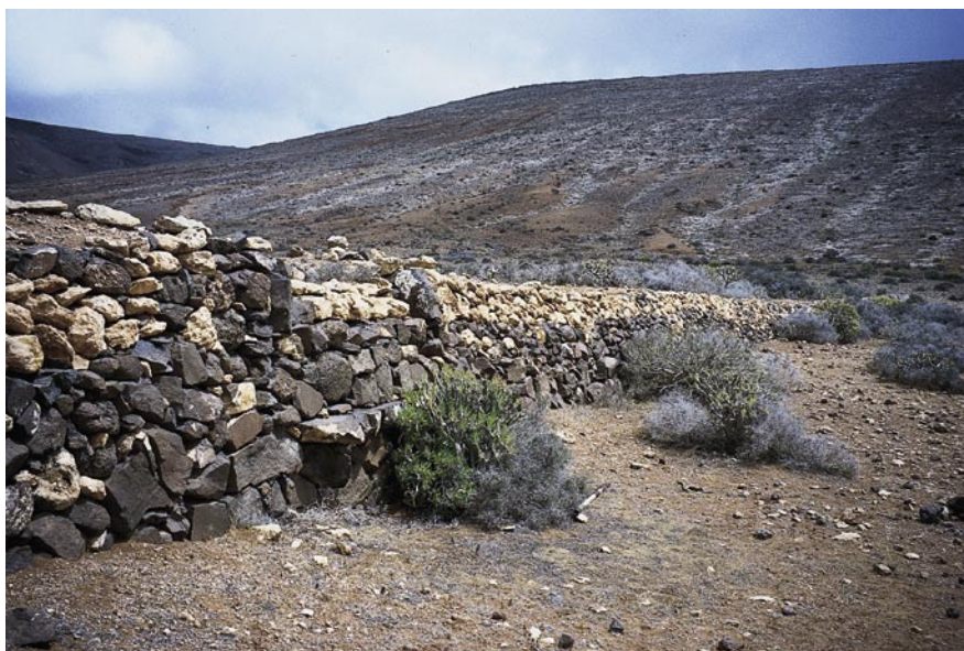
Figura 9: Pared de una gavia abandonada en La Vega de San José con signos de haber sido encabezada. Las lajas de piedra sobresalientes al pie del desagüe evitaban que el agua incidiera directamente sobre la base de la pared.
