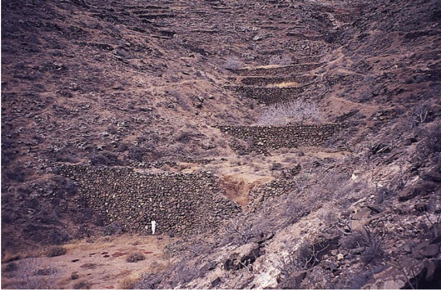
Figura 2: Traveseros en el Barranco Curbelo. La figura situada al pie de la pared inferior nos da una idea de su magnitud.
