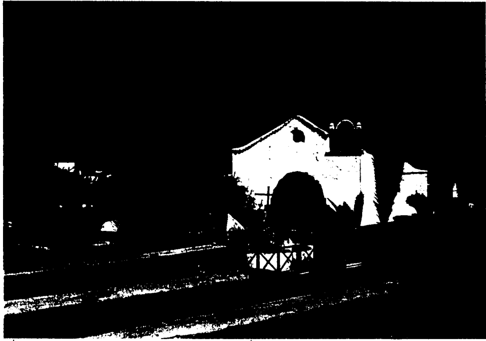
3. Ermita de San Leandro, incluida en el Inventario del Patrimonio Arquitectónico
